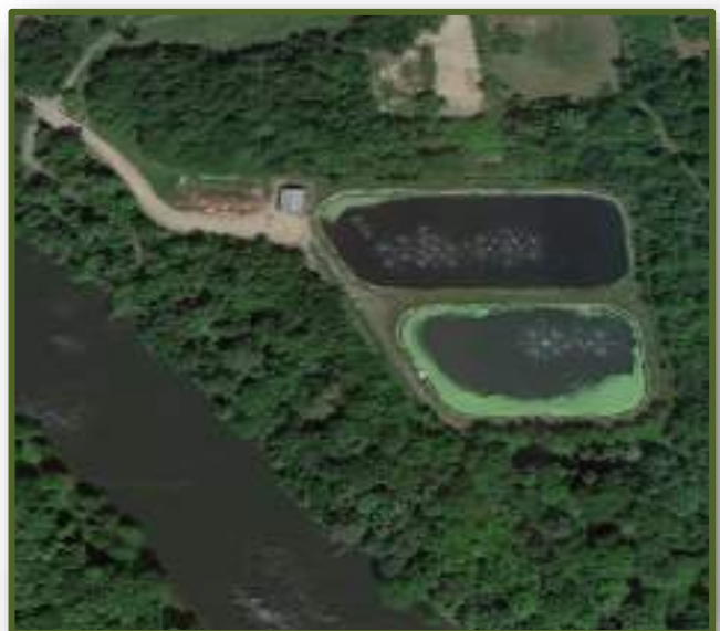
Traitement des eaux usées, les bassins. Municipalité de Plaisance
